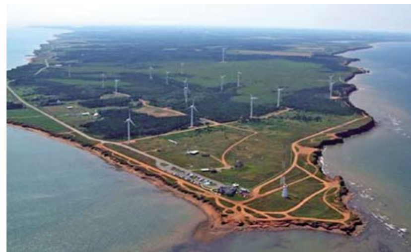
Usina Remota de Turbina Eólica
