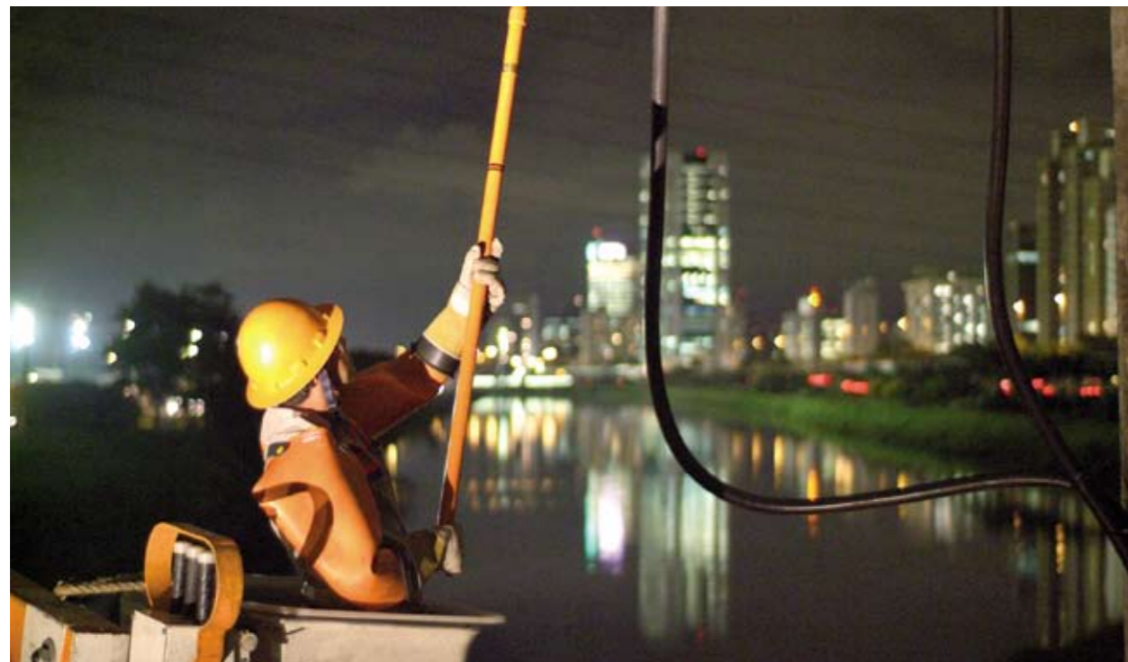
Colaborador da AES Eletropaulo trabalhando na rede de distribuição
