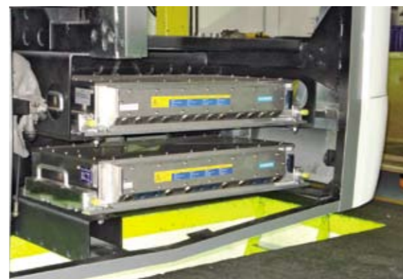
Instalação mecânica dos componentes da eletrônica de potência.
