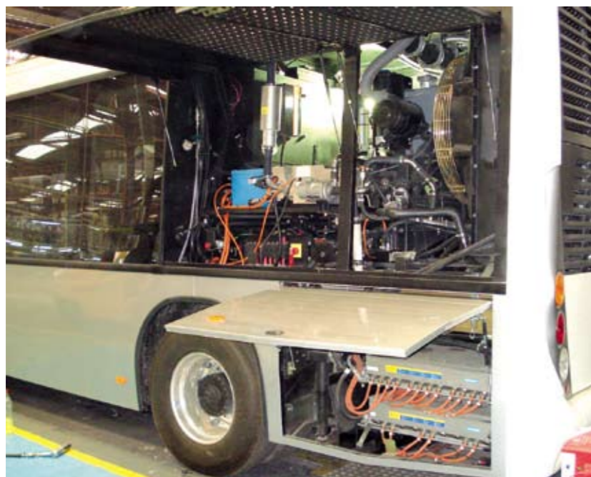
Instalações dos circuitos de alta tensão e da eletrônica de controle.
